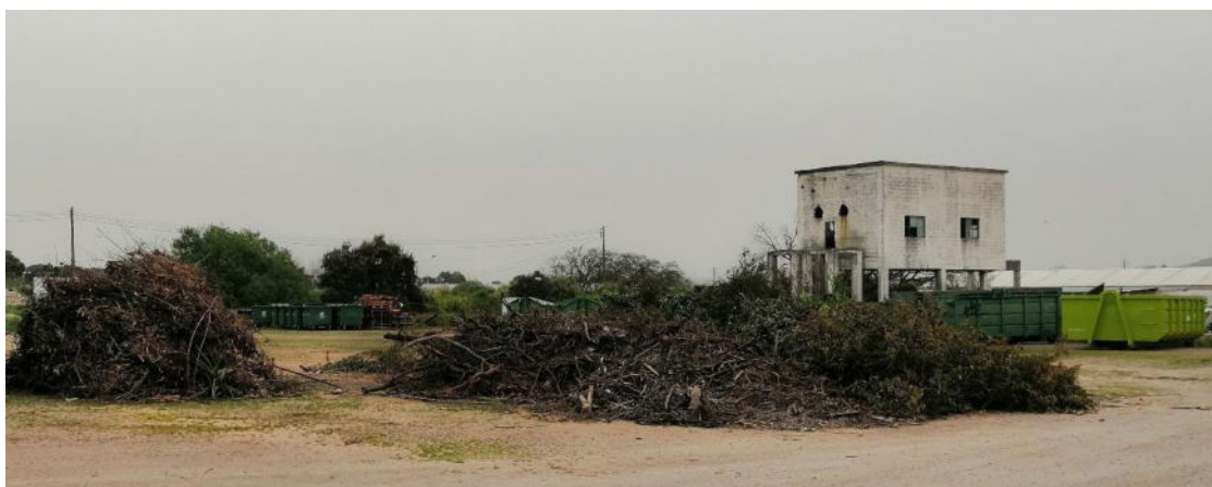
Imagem 7 – Armazenamento e destroçamento de ramagens em estaleiro recolhidas com contentor metálico
