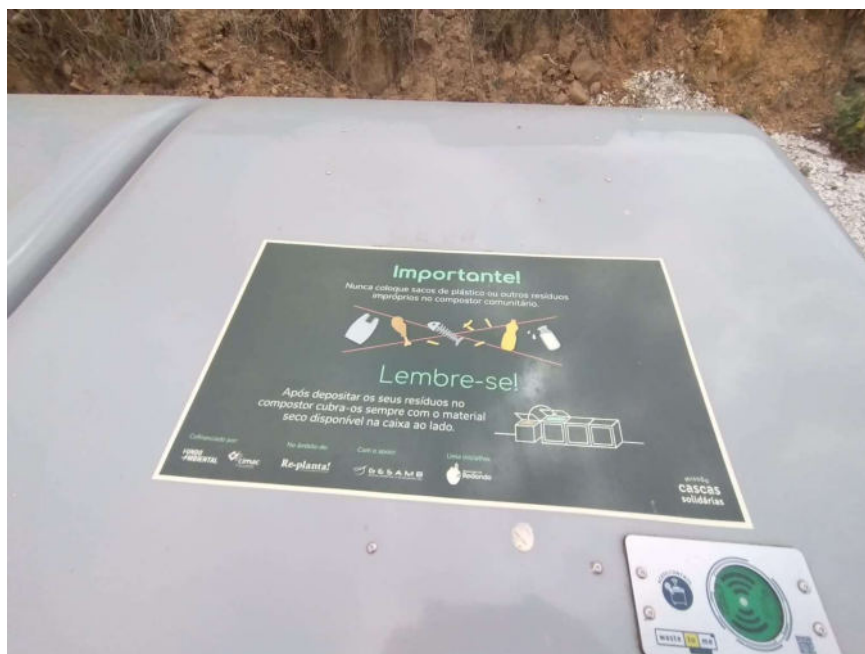
Imagem 5 – Compostor com /tampa de fibra de vidro e controlo de acesso Bairro Horta do Letras
