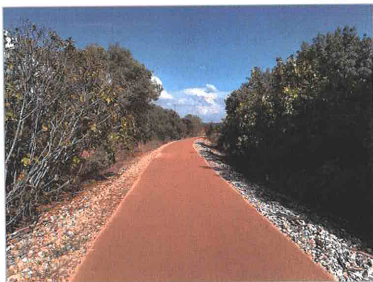
Figura 12 Ecopista de Reguengos
