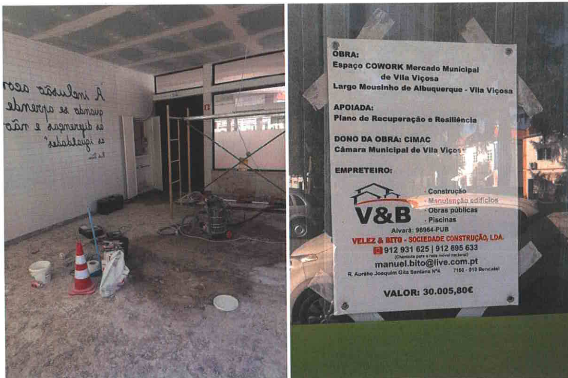
Figura 57 Obra Espaço de Cowork Vila Viçosa
