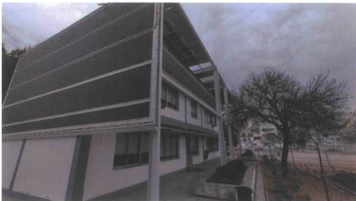
Figura 5 Fachada poente. Parede verde antes da plantação (Sistema hidropónico e protótipo mBIGToldo)
