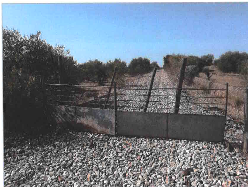
Figura 7 Ramal de Reguengos após levantamento dos materiais de via (carris e sulipas)
