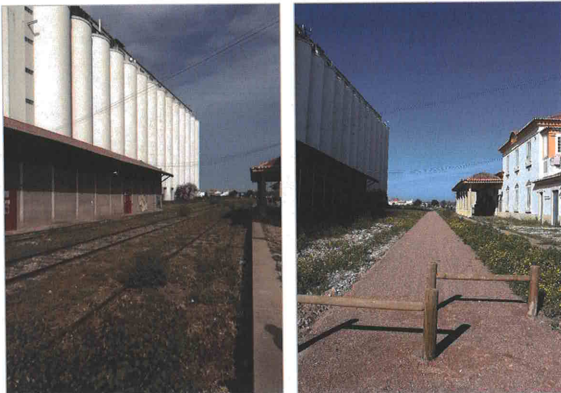
Figura 10 Estação de Reguengos, antes e após a intervenção realizada na empreitada de implementação da Ecopista
