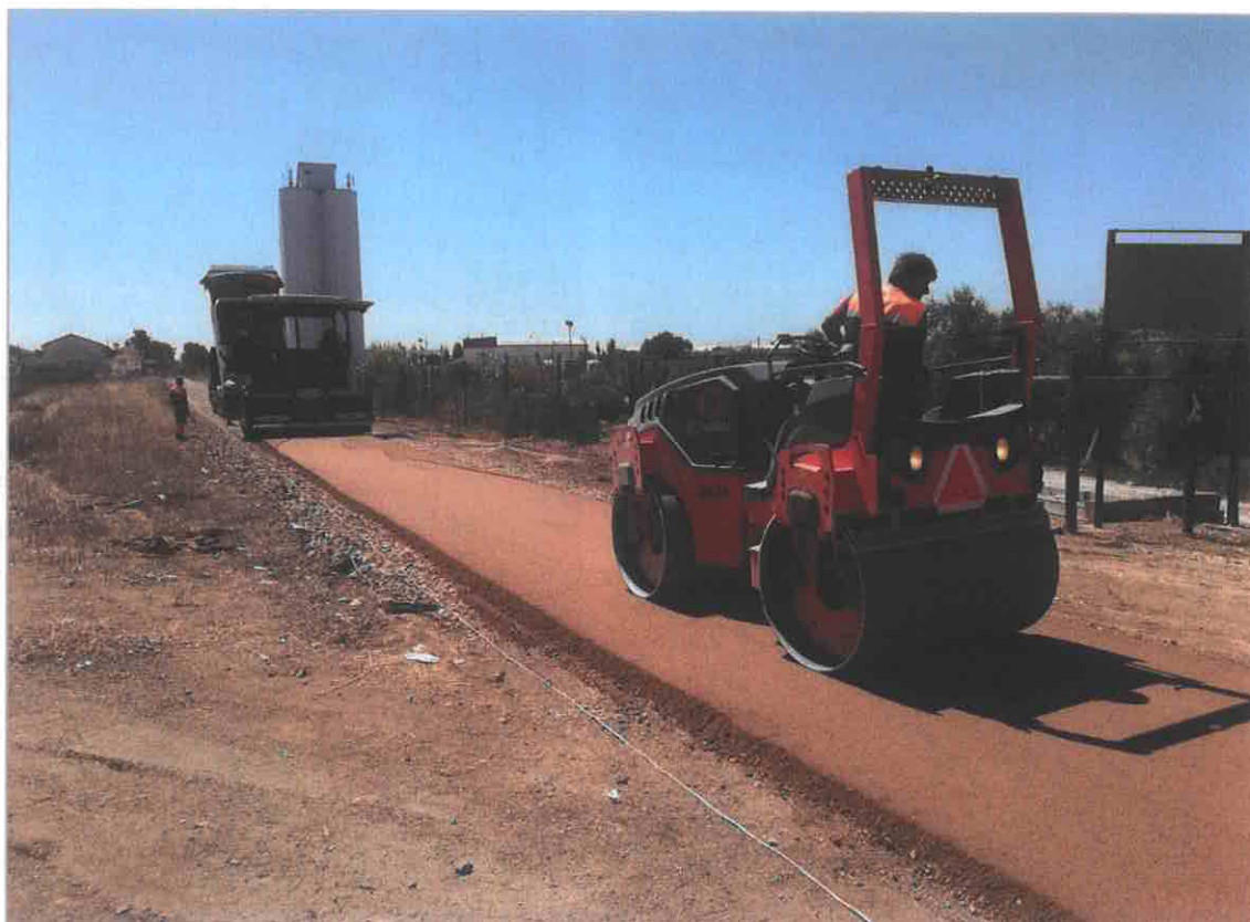
Figura 8 Realização de troço experimental no início das obras da empreitada da Ecopista de Reguengos
