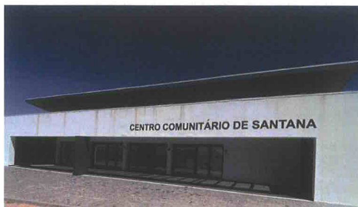
Figura 64 PI 9.7 - Ampliação do Centro Comunitário de Santana
