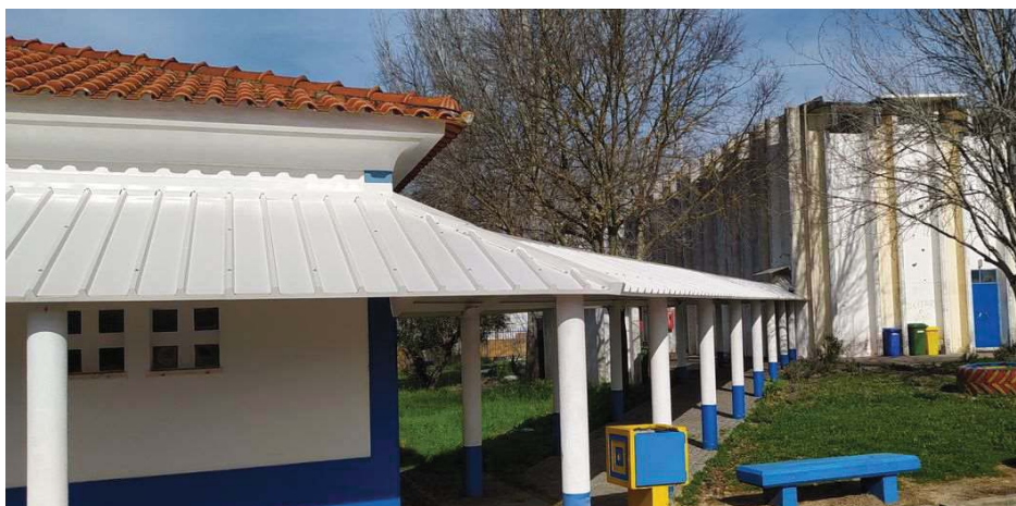
PI 10.5 - Remoção de Fibrocimento na Escola Básica Sebastião da Gama, em Estremoz
