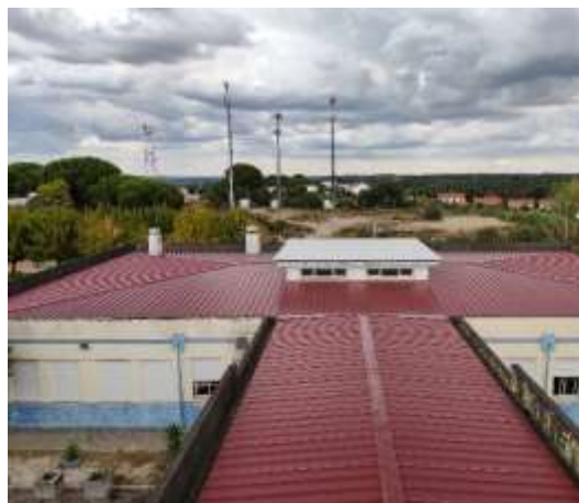
PI 10.5 - Remoção Fibrocimento - Escola EB 2,3 de Mora
