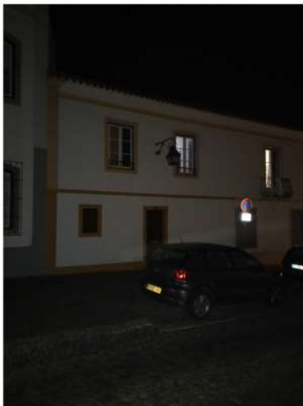
Exemplo de avaria na Iluminação Pública
